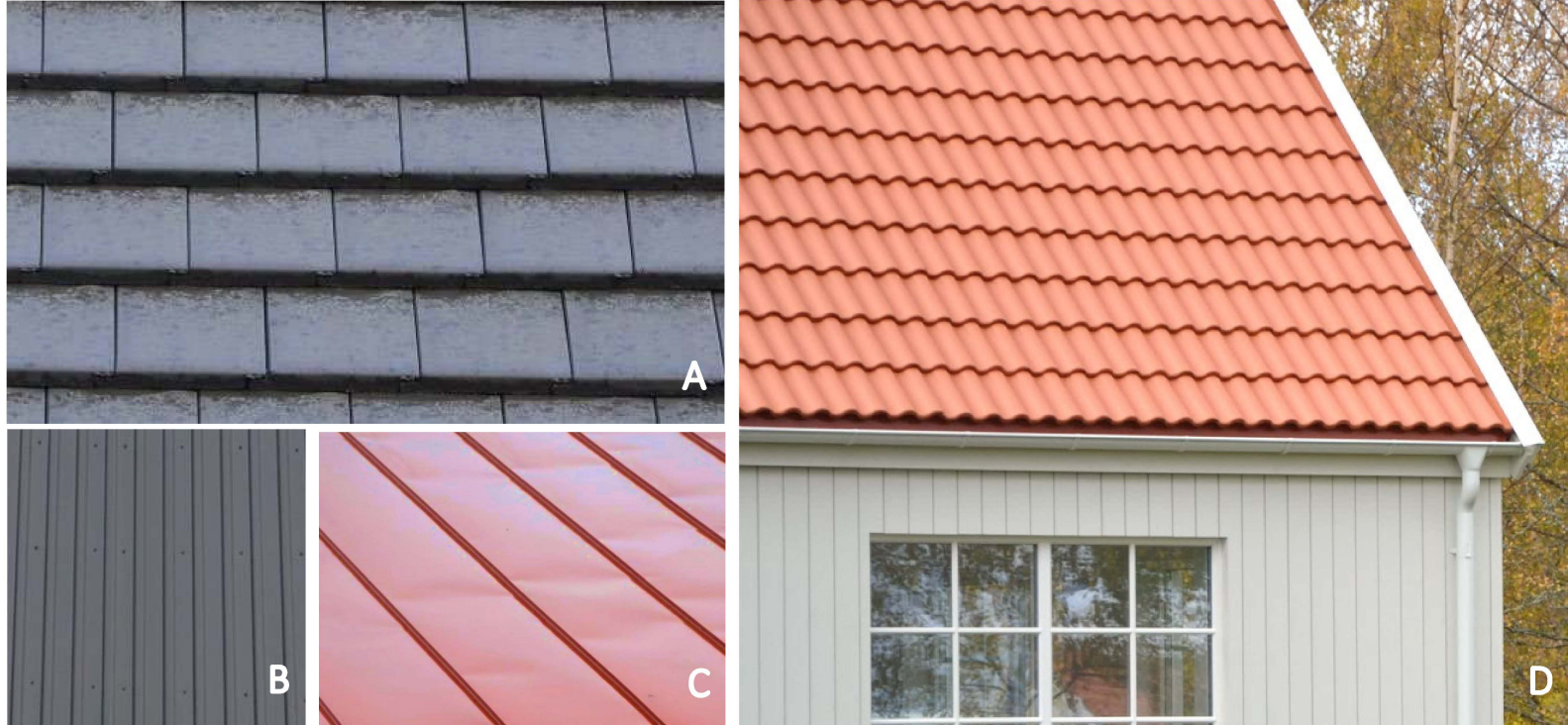
Exempel på olika takmaterial, betongpannor i skifferliknande utformning (A), trapetsplåt (B), falsad röd plåt (C) och röda betongpannor (D).
