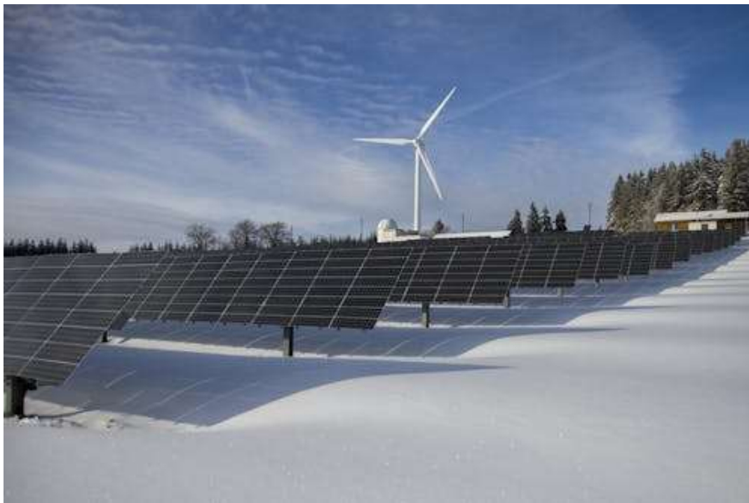
Figur 19. Vindkraftverk kombinerad med solcellspark.
